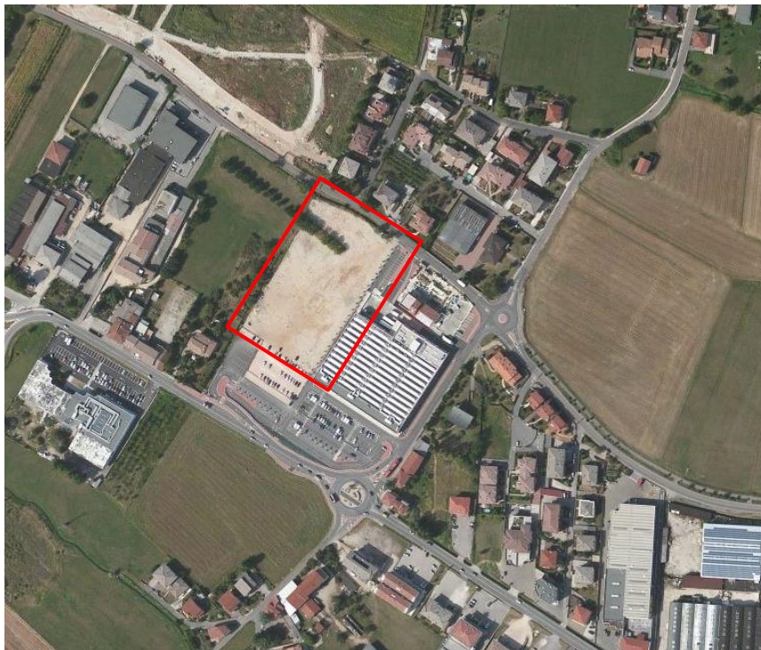
Figura 1 – Foto aerea della zona dell'intervento
